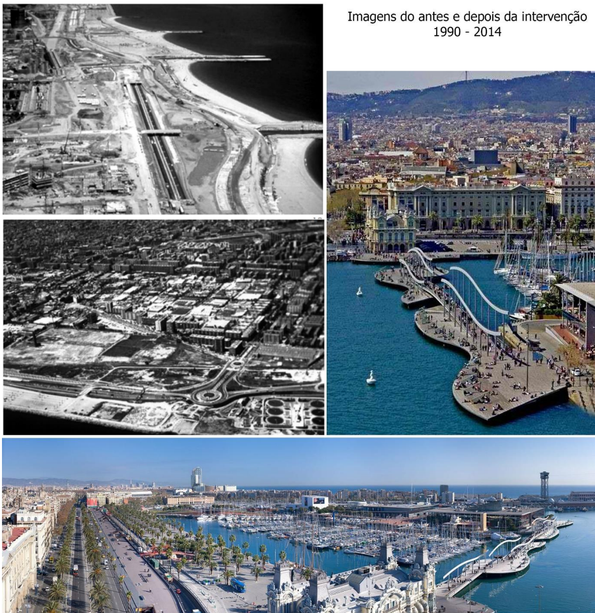
Figura 12: Barcelona antes e depois das intervenções.
