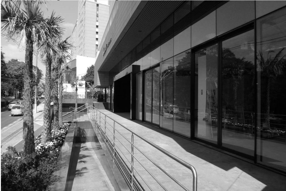
Figura 10 – Aspectos Tecnológicos do Edifício Toulon Office Center
