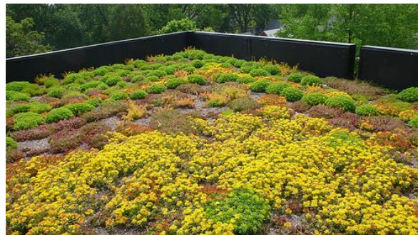
Figura 02. Exemplo de telhado verde extensivo.
