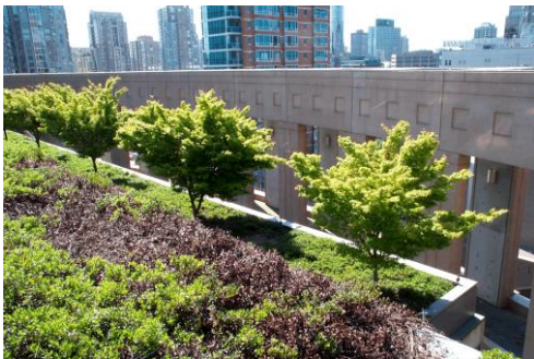
Figura 01. Exemplo de telhado verde intensivo.
