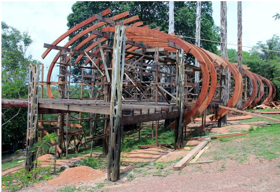
Figura 18. Estrutura dos apartamentos em etapa de construção.
