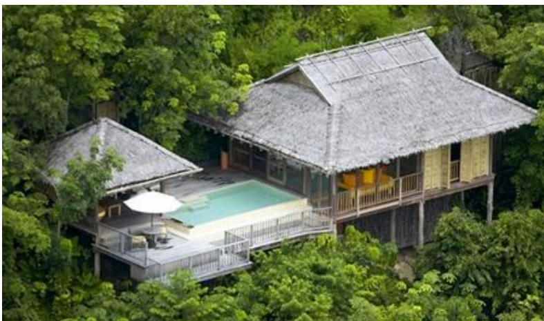
Figura 11. Estrutura de pilares e cobertura.
