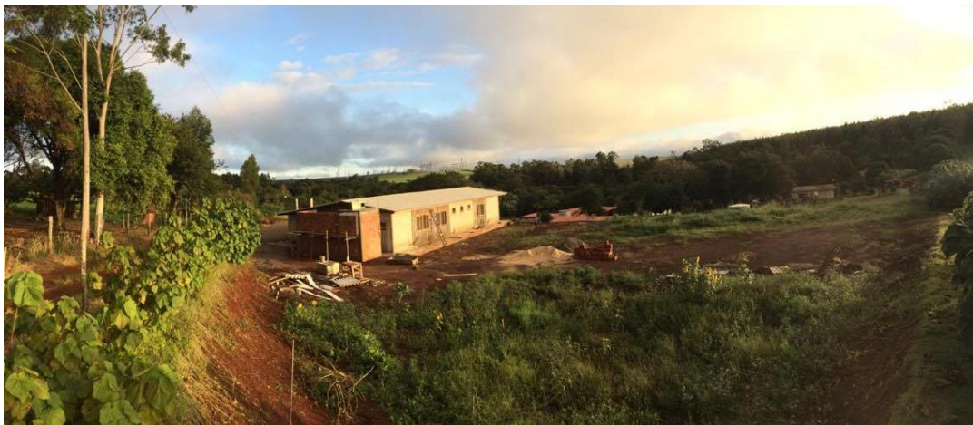
Figura 47. Vista 02 do terreno.
