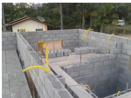
Figura 10 – Alvenaria de vedação
