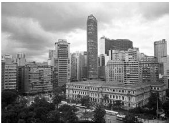
Figura 03 - Edifícios em construção no Vale do Anhangabaú - 1927
