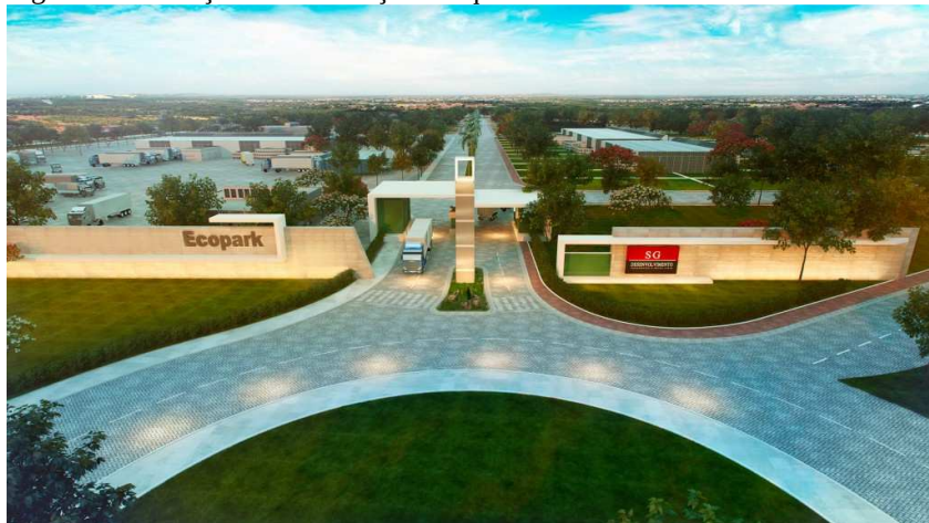
Figura 7: Utilização de iluminação adequada
