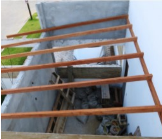
Figura 06: Estrutura de madeira.
