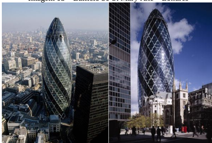
Imagem 03 – Edifício 30 St Mary Axe – Londres
