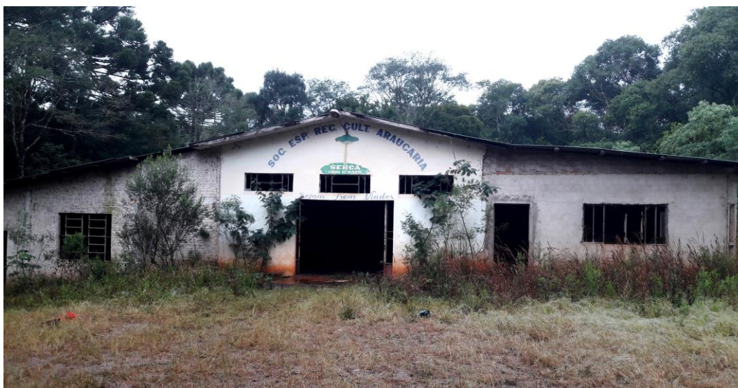
Figura 02 – Fachada Principal do Clube “SERCA”
