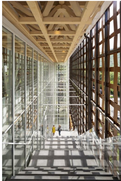
Figura 18 – Detalhe da parte interna
