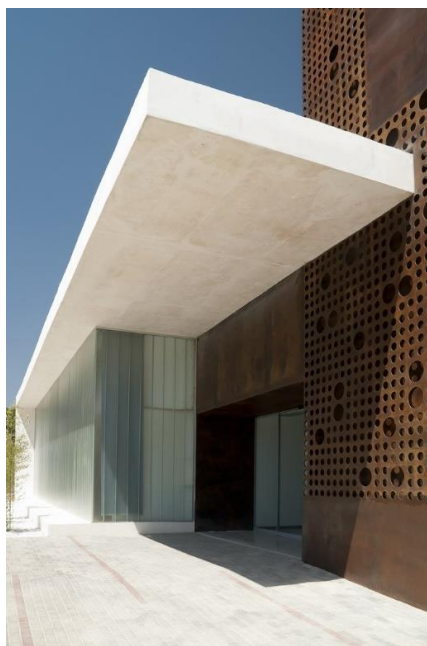
Figura 08 – Detalhe da fachada
