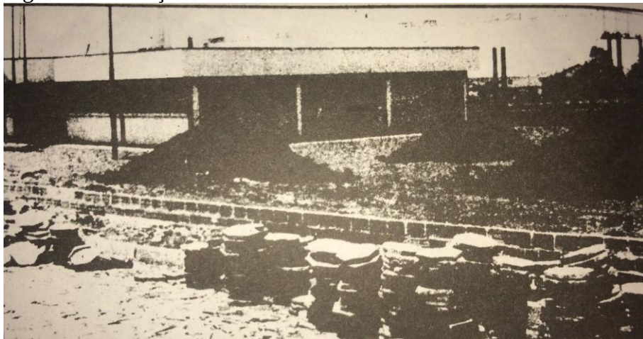
Figura 8 - Execução dos trabalhos finais do atual Terminal Rodoviário.
