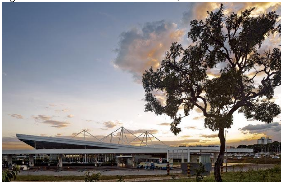
Figura 14 - Terminal Rodoviário de Brasília, Distrito Federal.
