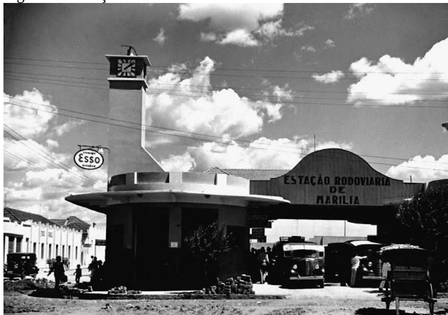
Figura 4 – Estação ferroviária de Marília.
