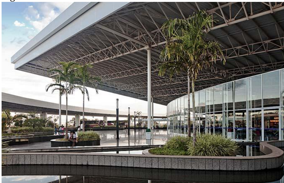
Figura 17 – Área social do Terminal.
