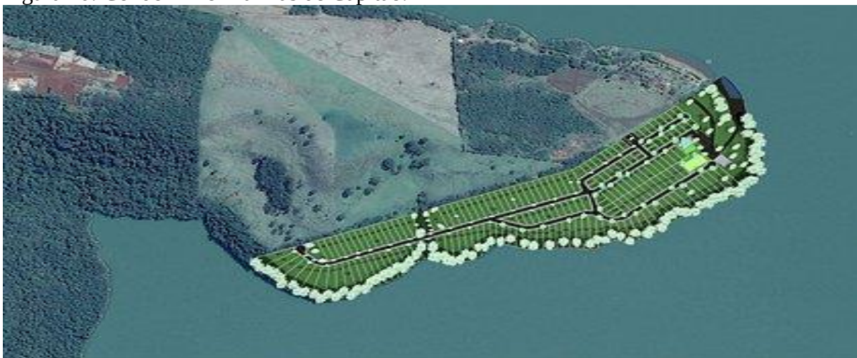
Figura 20: Condomínio Marinas de Capitão.
