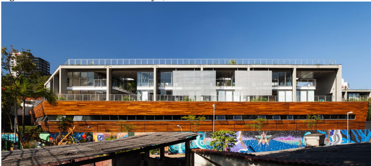
Figura 10 – Fachada do Edifício Corujas, 2016.
