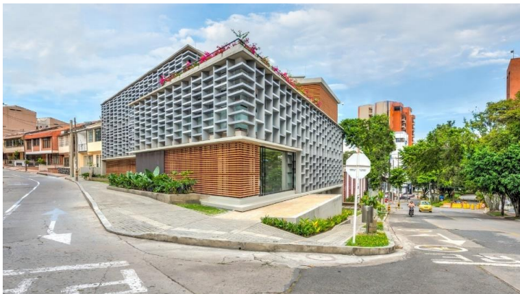
Figura 07 – Vista Edifício Spectra
