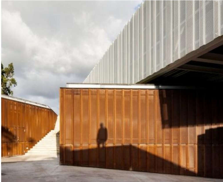
Figura 02: Painéis em aço como vedação - Parque Tecnológico em Óbidos.
