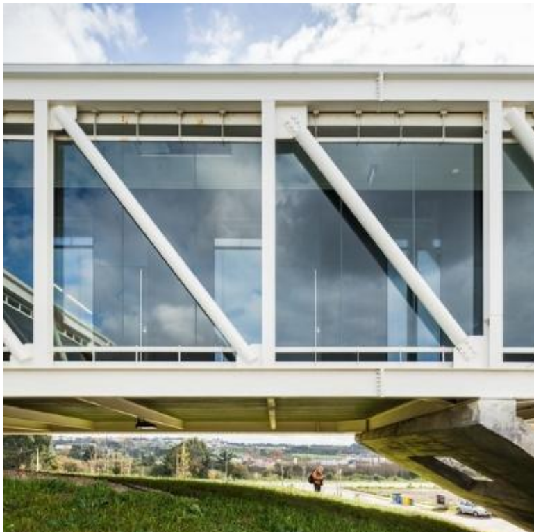
Figura 03: Utilização do vidro juntamente com estrutura de aço em fachadas - Parque Tecnológico em Óbidos.
