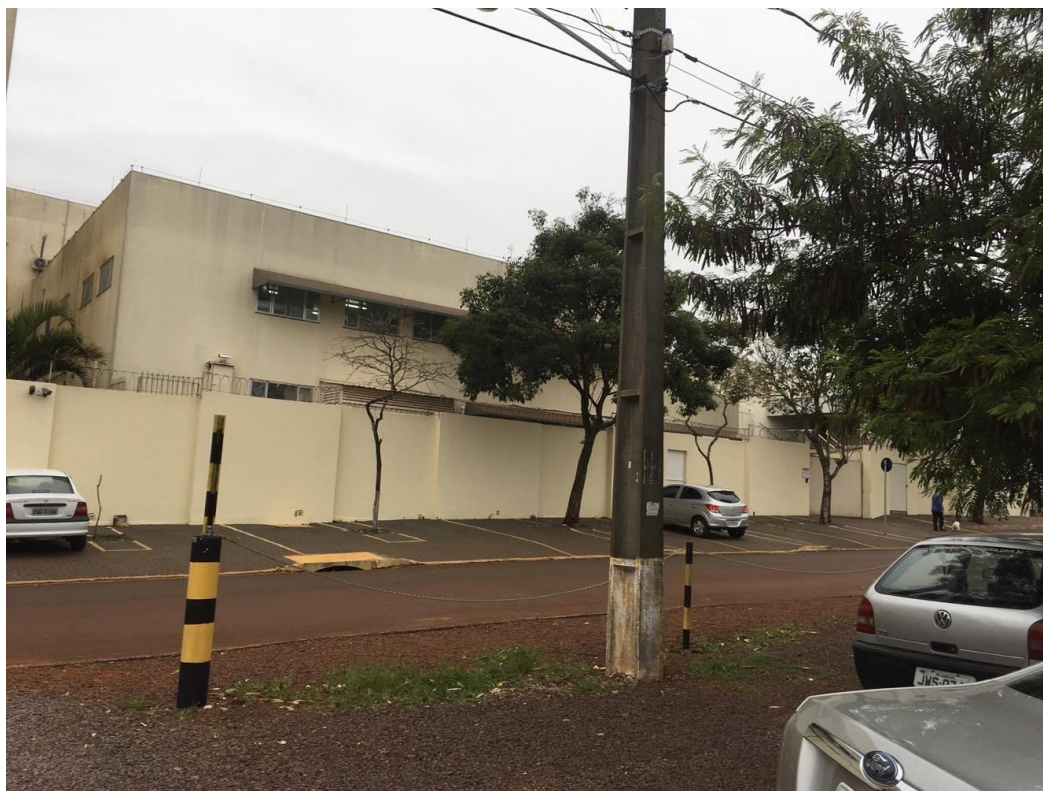
Figura 27 – Foto da Lateral do Hospital UOPECAN em frente ao terreno
