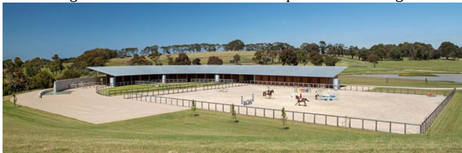
Figura 06: Vista externa da obra Equestrian Buildings.
