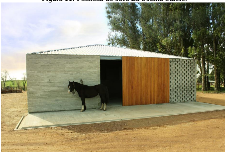
Figura 11: Fachada da obra La Solana Stable.
