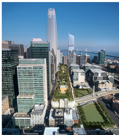
Figura 12: Transbay Center, São Francisco, Califórnia
