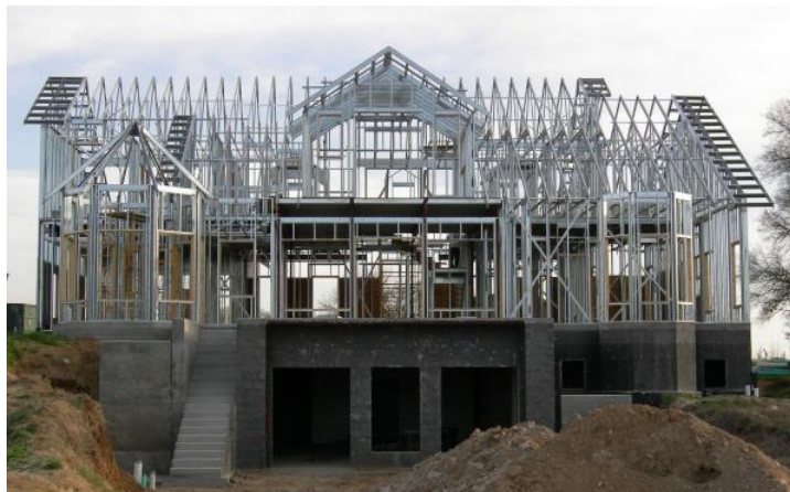
Figura 01. Execução de residência em steel framing.
