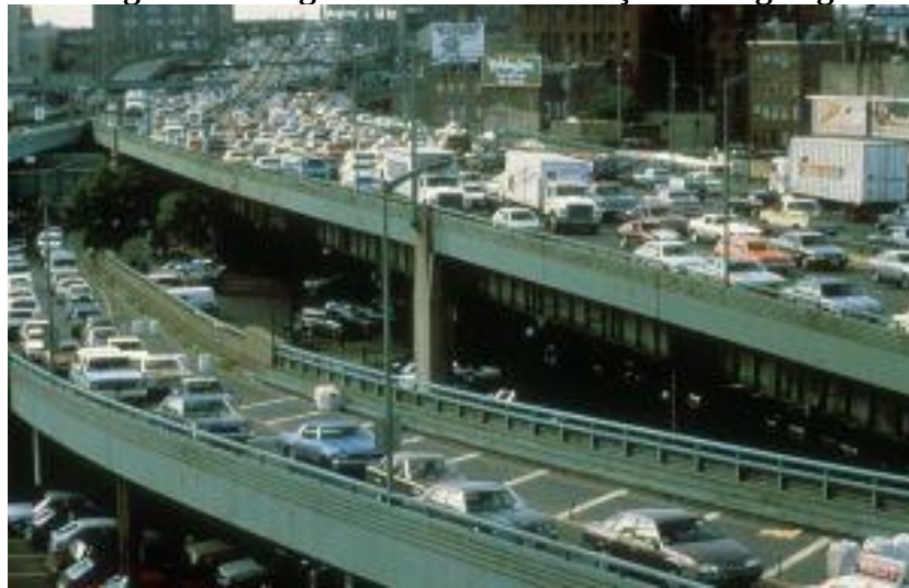
Figura 10: Região antes da construção do Big Dig
