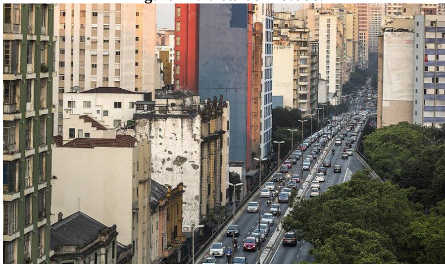
Figura 14: Vista do Elevado.
