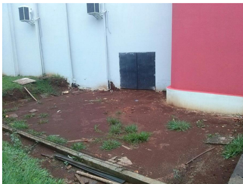
Figura 20 - Instalação da saída de emergência no teatro existente
