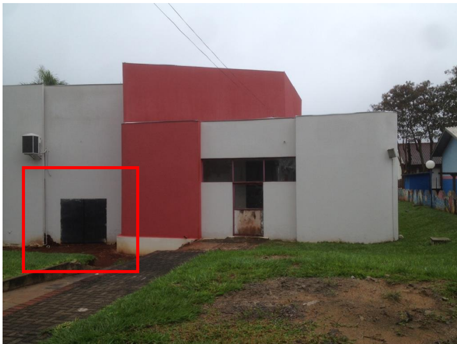
Figura 19 - Instalação da saída de emergência no teatro existente vista da rua
