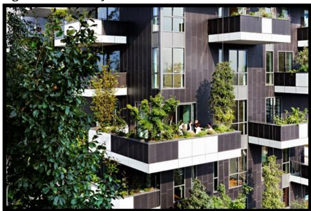
Figura 13 - Terraços Verdes do Edifício
