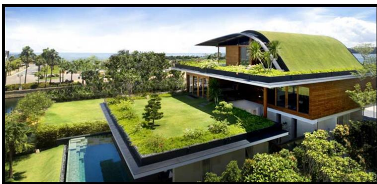
Figura 1 Cobertura plana (à direita) e inclinada (a esquerda) em uma mesma edificação.
