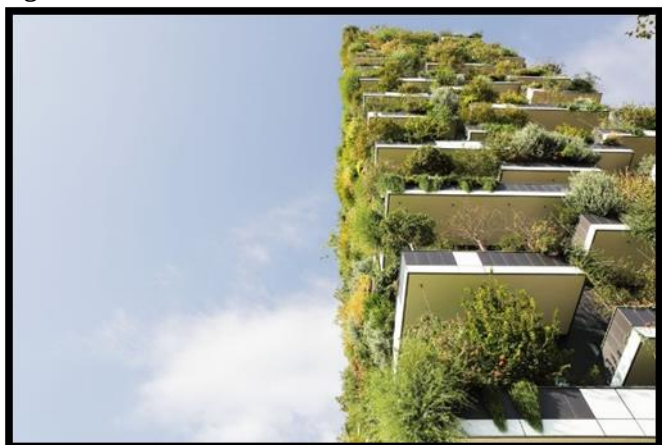
Figura 12- Fachada do Edifício Bosco Verticale
