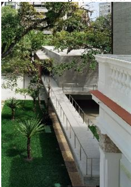
Figura 05: Obra antiga se relaciona com o anexo
