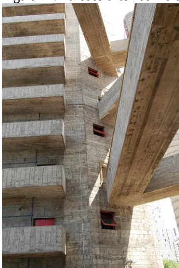
Figura 17: Paredes externas moldadas com tábuas horizontais de madeira
