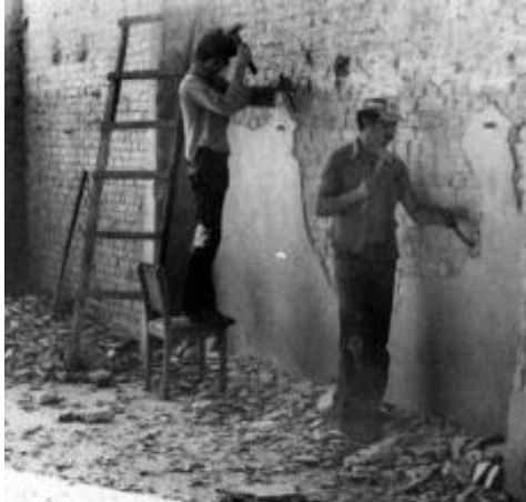
Figura 19: Retirada dos rebocos das paredes do galpão de atividades gerais
