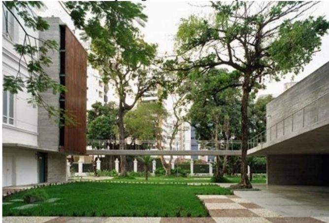
Figura 07: Passarela que liga as duas edificações
