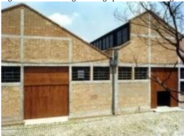
Figura 20: Paredes originais do galpão de atividades gerais após a retirada do reboco
