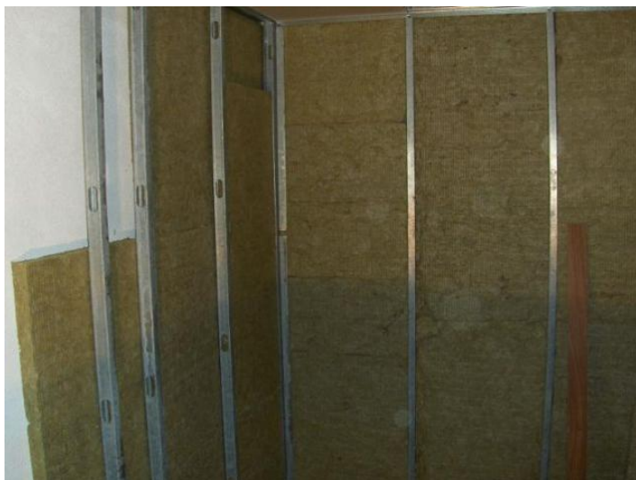
Figura 21: Lã de rocha aplicada.
