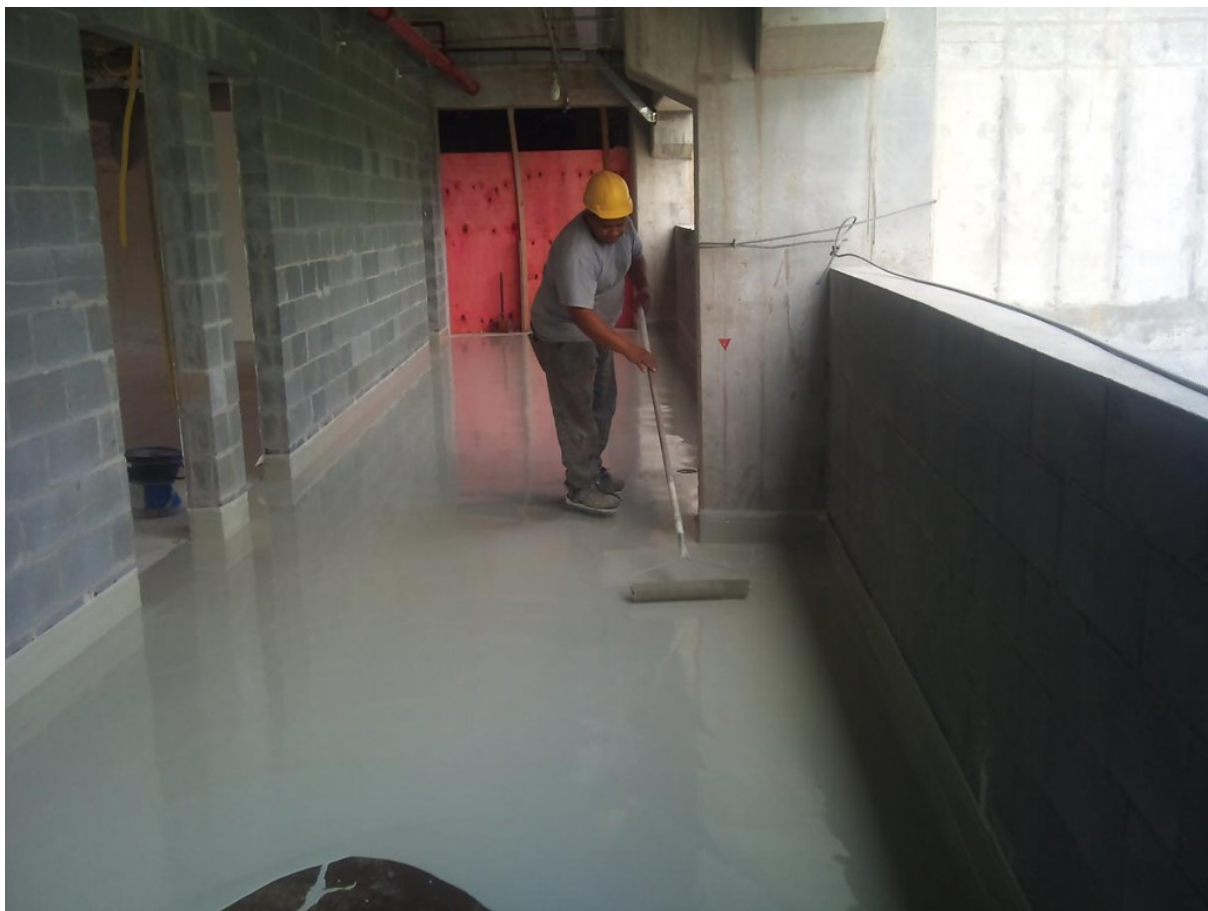
Figura 24: Piso de poliuretano na Arena Allianz parque
