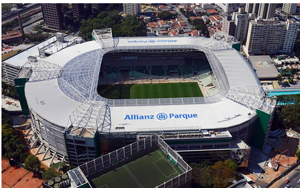
Figura – Telha zipada na Arena Allianz Parque.
