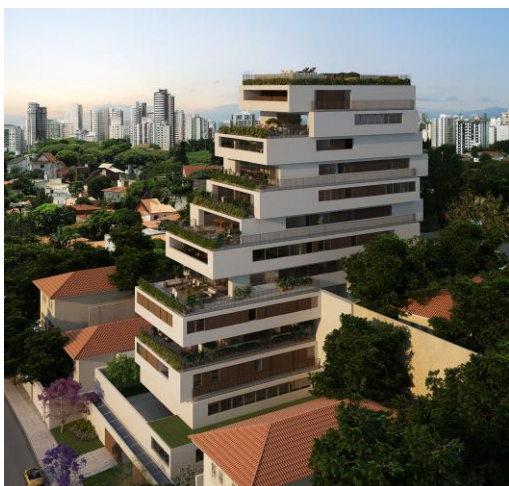
Figura 24 - Edifício Oka inserido em meio a paisagem
