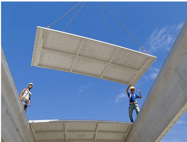
Figura 1 – Laje pré-fabricada sendo transportada e colocada na construção
