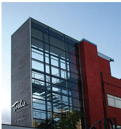
Figura 26 - Estrutura e Elemento envidraçado do Salão Toshie
