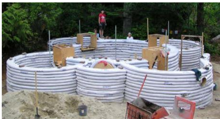
Figura 2 - Técnica construtiva superadobe
