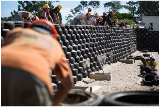
Figura 18 - Muro de contenção
