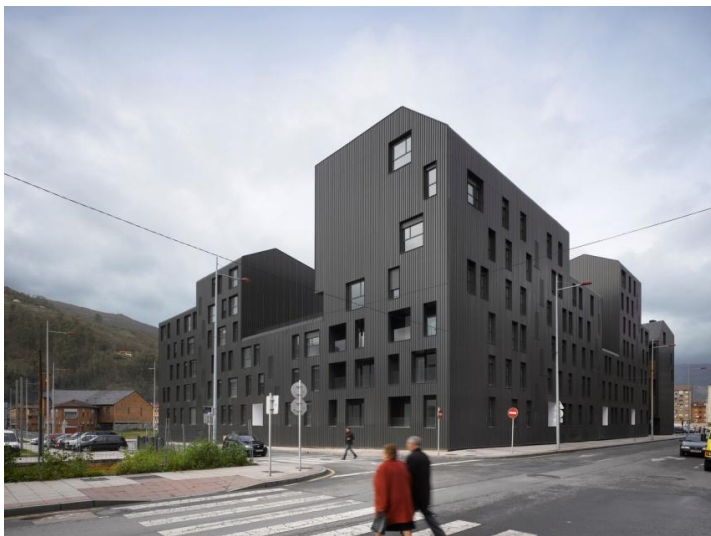
Figura 13 - Fachada em aço Habitação Social Vivazz
