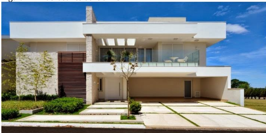
Figura 17 - Fachada residência ACP
