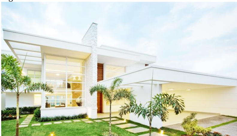
Figura 16 – Fachada residência CS
