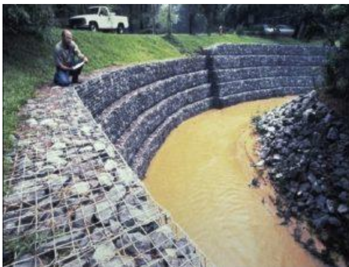
Figura 03: Muro de suporte construído utilizando gabhões.
