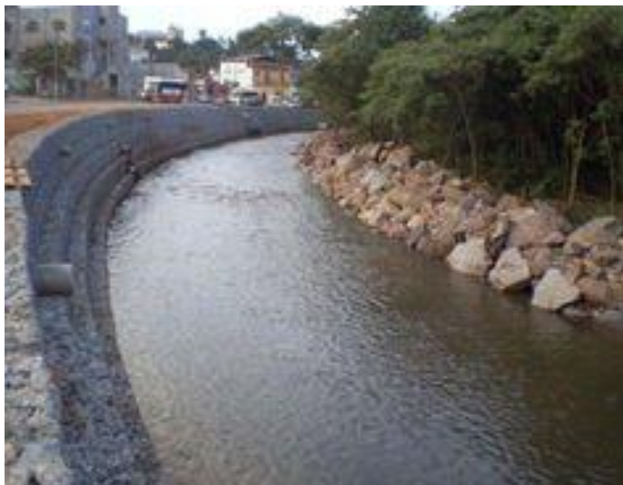
Figura 04: Proteção de encosta de rio em Gabiões -Sabará, Minas Gerais.
