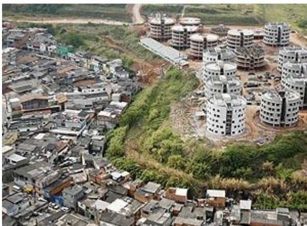
Figura 8 - Vista aérea do Condomínio
