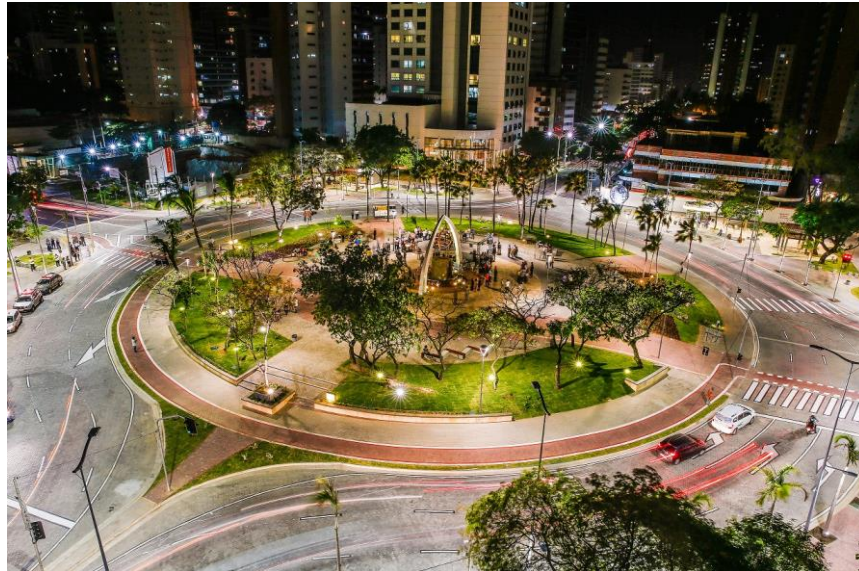
Figura 14 – Praça Portugal após projeto de requalificação
