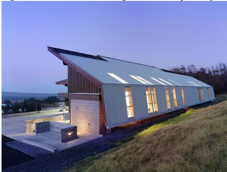
Figura 9 - Laboratório de Energia Hawaii Preparatory Academy
