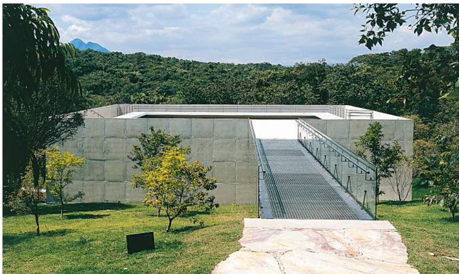
Figura 10: Passarela metálica que liga a cobertura da galeria a parte mais alta do terreno
