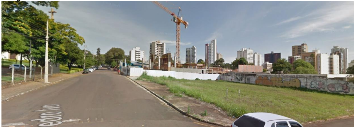
Imagem 08 – Vista do terreno e da rua Pedro Ivo
