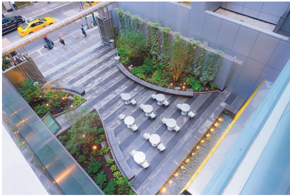
Figura 10 – Vista aérea 50th Street Commons
