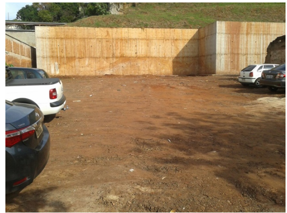
Figura 16 - Vista Frontal terreno
