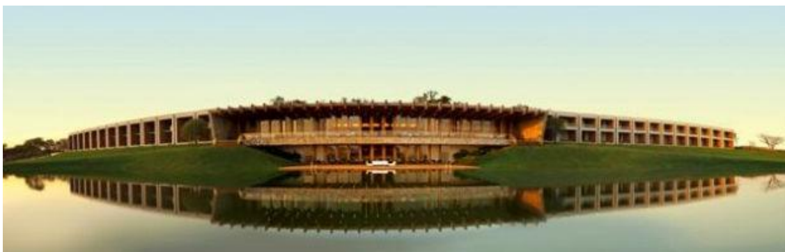
Figura 01: Fachada Panorâmica Fasano Hotel Boa Vista
