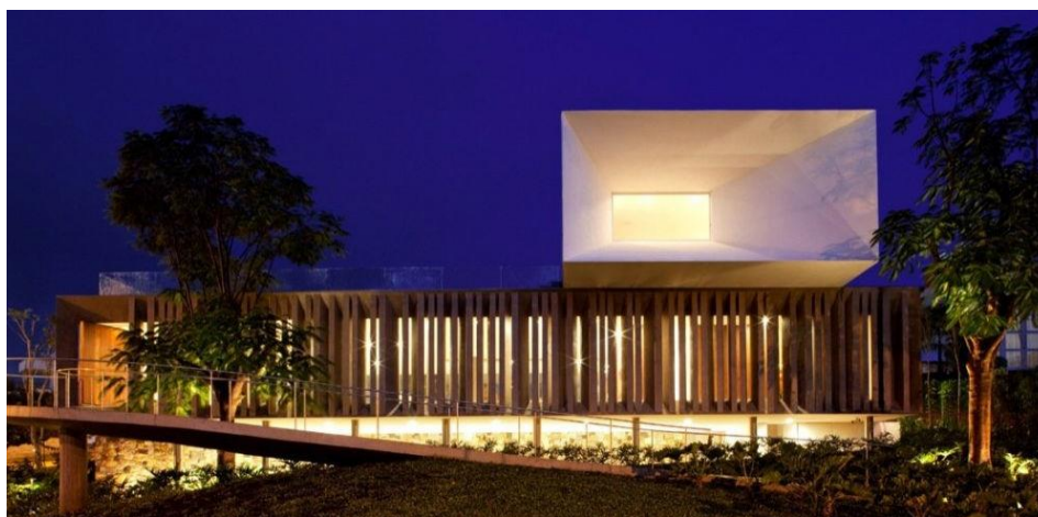
Figura 10: Fachada Principal, Casa Piracicaba
