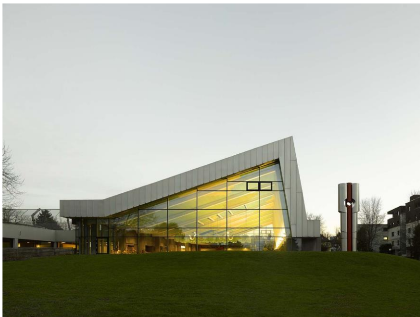
Figura 2: Detalhe em vidro da fachada do Centro Esportivo em Leonberg
