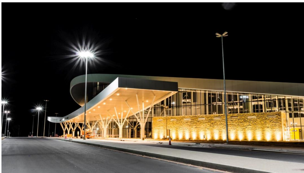
Figura 6: Estrutura e cobertura do Aeroporto de Nacala.
