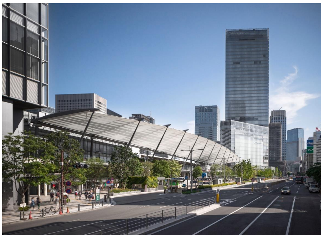
Figura 3: Reforma da estação de Tóquio Yaesu
