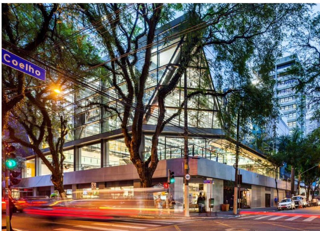
Figura 1 – Edifício Esportivo do Colégio São Luís
