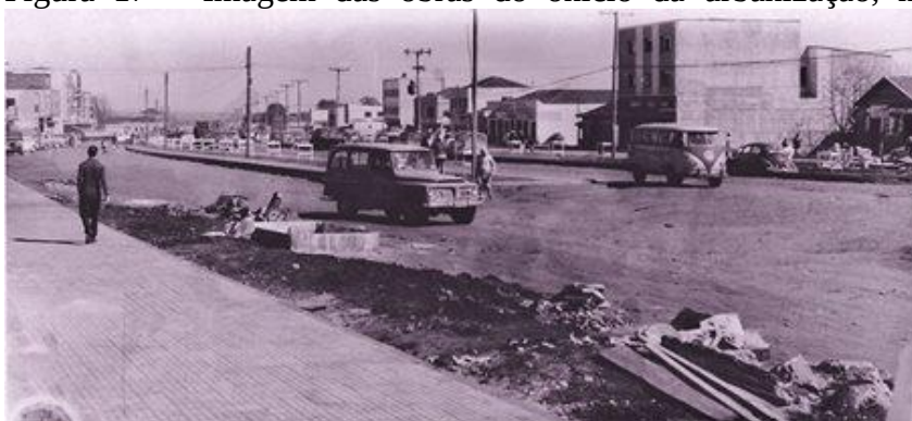
Figura 17 – Imagem das obras do onício da urbanização, meados da década de 1960.
