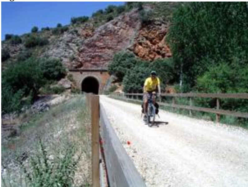
Figura 07 – Túnel da Via Verde Sierra de Alcaraz.
