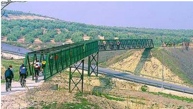
Figura 11 – Passarela do km 37.
