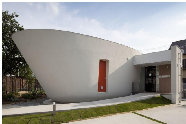
Figura 22: Perspectiva Externa Casa Green Screen Fonte: MARCON, 2013.
