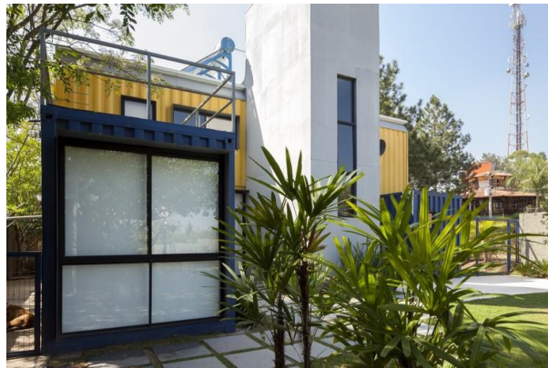
Figura 13: Perspectivas Externas Casa Contêiner Fonte: ArchDaily
