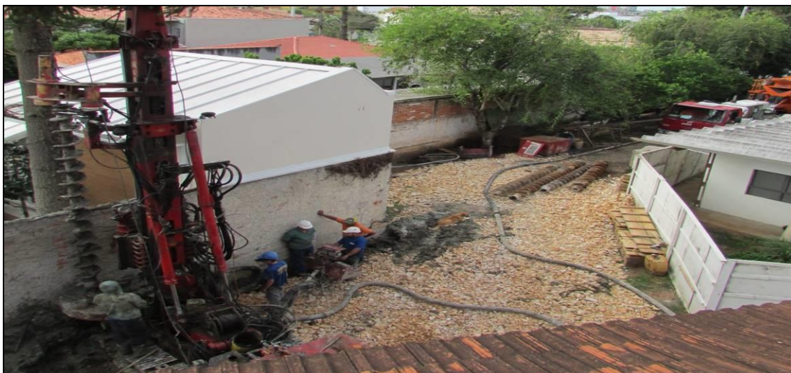
Figura 11 – Anexo sendo construído nos fundos do terreno
