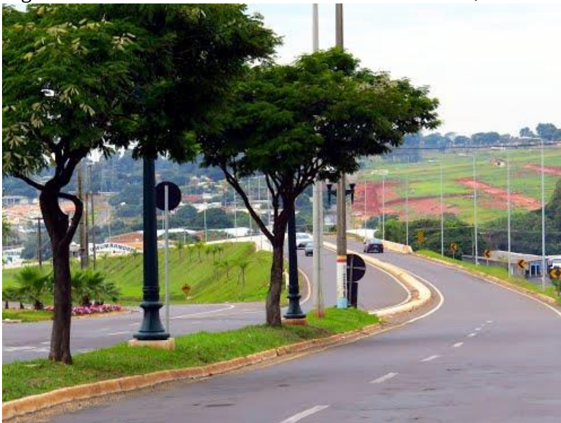
Figura 11 - Viaduto da Av. Tiradentes em Umuarama, PR.
