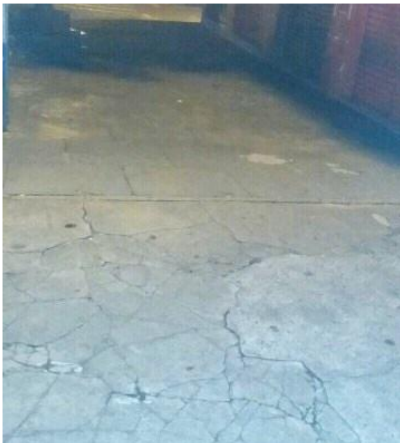
Figura 13- Calçada Avenida Londrina.
