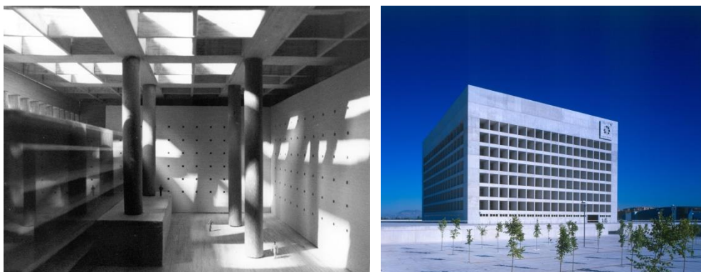
Figura 29 e 30 – Caja Granada, Espanha
