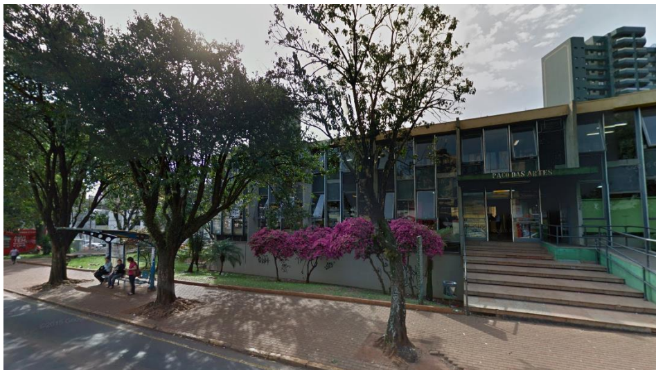
Figura 8: Entrada Principal pela Rua Paraná.
