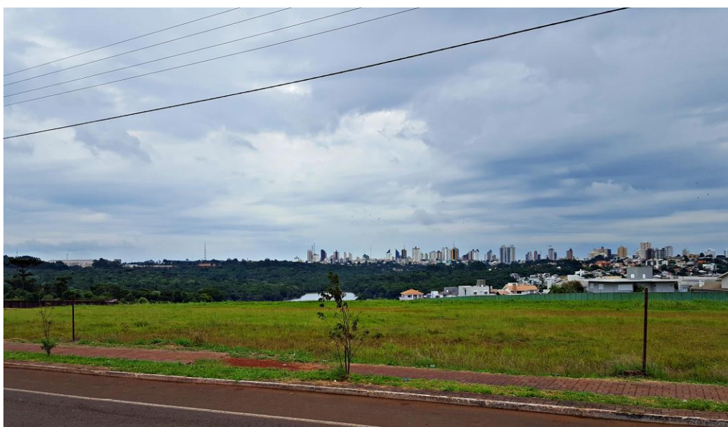
Figura 14: Vista do terreno pela Avenida Rocha Pombo.
