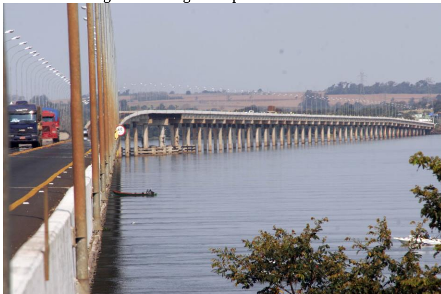
Figura 21: Imagem da ponte do Rio Paraná
