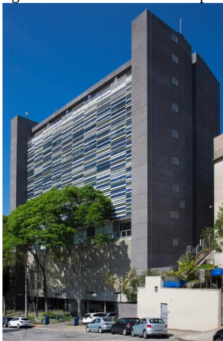
Figura 08: Edifício Retrofit Scopus
