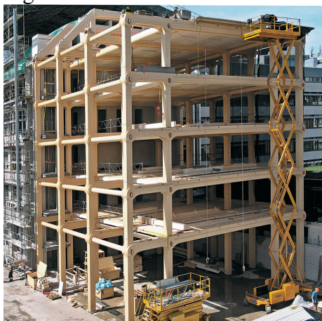
Figura 21 - Edifício Tamedia extrutura
