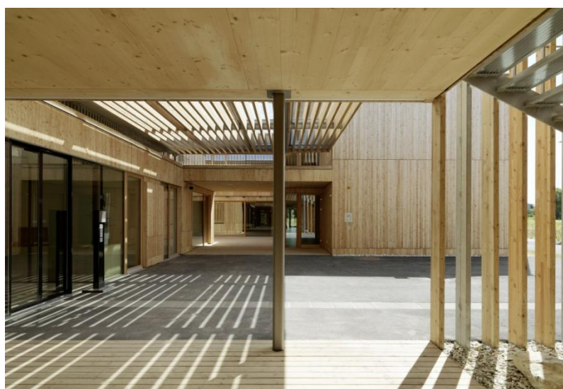
Figura 16 – Vista da estrutura em madeira
