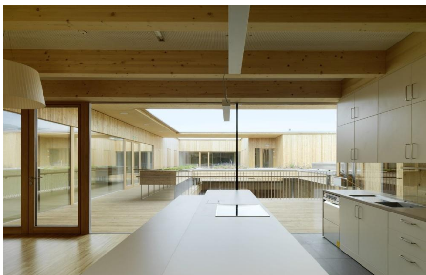
Figura 15 – Vista das vigas em madeira
