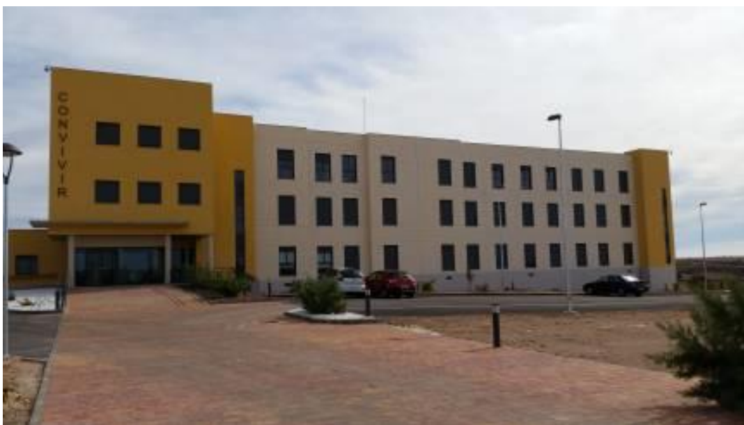
Figura 03: Fachada de entrada Convivir.
