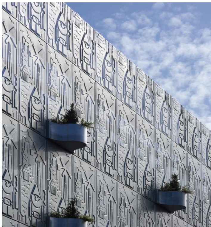
Figura 09 – Detalhes da fachada
