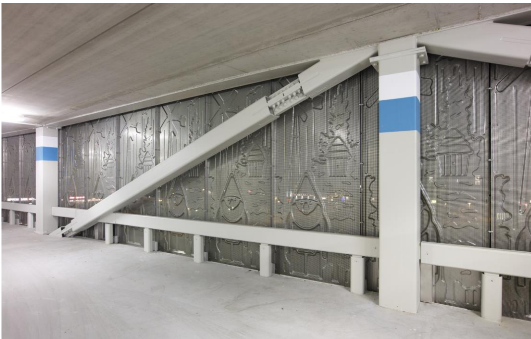
Figura 11 – Vista interna dos painéis
