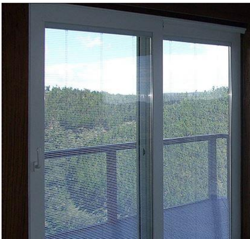
Figura 17: Vidro insulado com micropersianas
