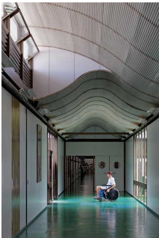
Figura 29: Iluminação natural é feita por meio dos sheds
