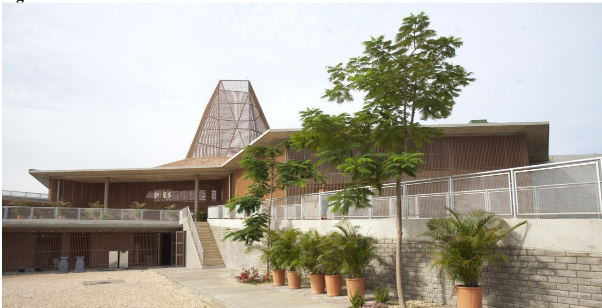
Figura 12 - Detalhe de um dos acessos e materiais do edifício.
